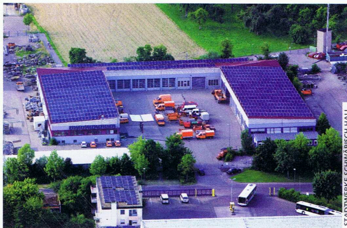
Eine von vielen: Solaranlage in Bürgerhand auf dem Dach des Werkhofs der Stadtwerke Schwäbisch Hall
