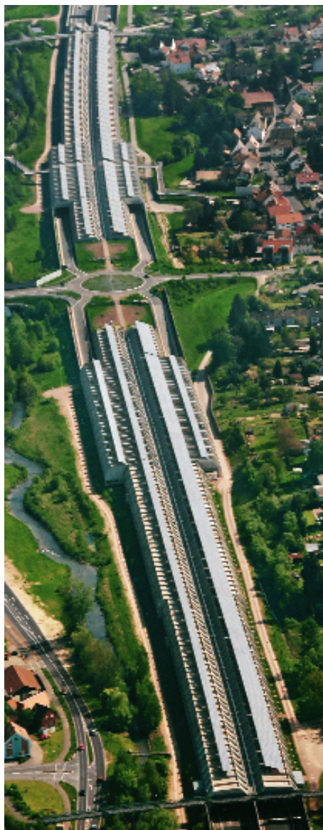
Die längste Photovoltaik-Anlage der Welt trägt die Autobahneinhausung in Goldbach-Hösbach. Bild: A 3 Solargesellschaft mbH
