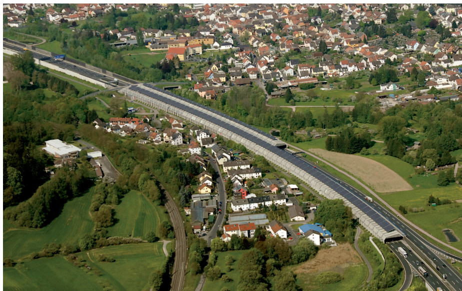
Durch Bürgerbeteiligung finanziert und akzeptiert: Die vermutlich längste Solaranlage der Welt auf der Autobahneinhausung der A3 im unterfränkischen Goldbach-Hösbach. © A3 Solargesellschaft mbH
