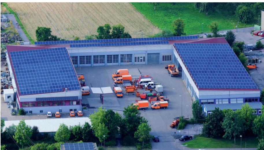
Eine von vielen: Solaranlage in Bürgerhand auf dem Dach des Werkhofs der Stadtwerke Schwäbisch Hall - © Stadtwerke Schwäbisch Hall GmbH
